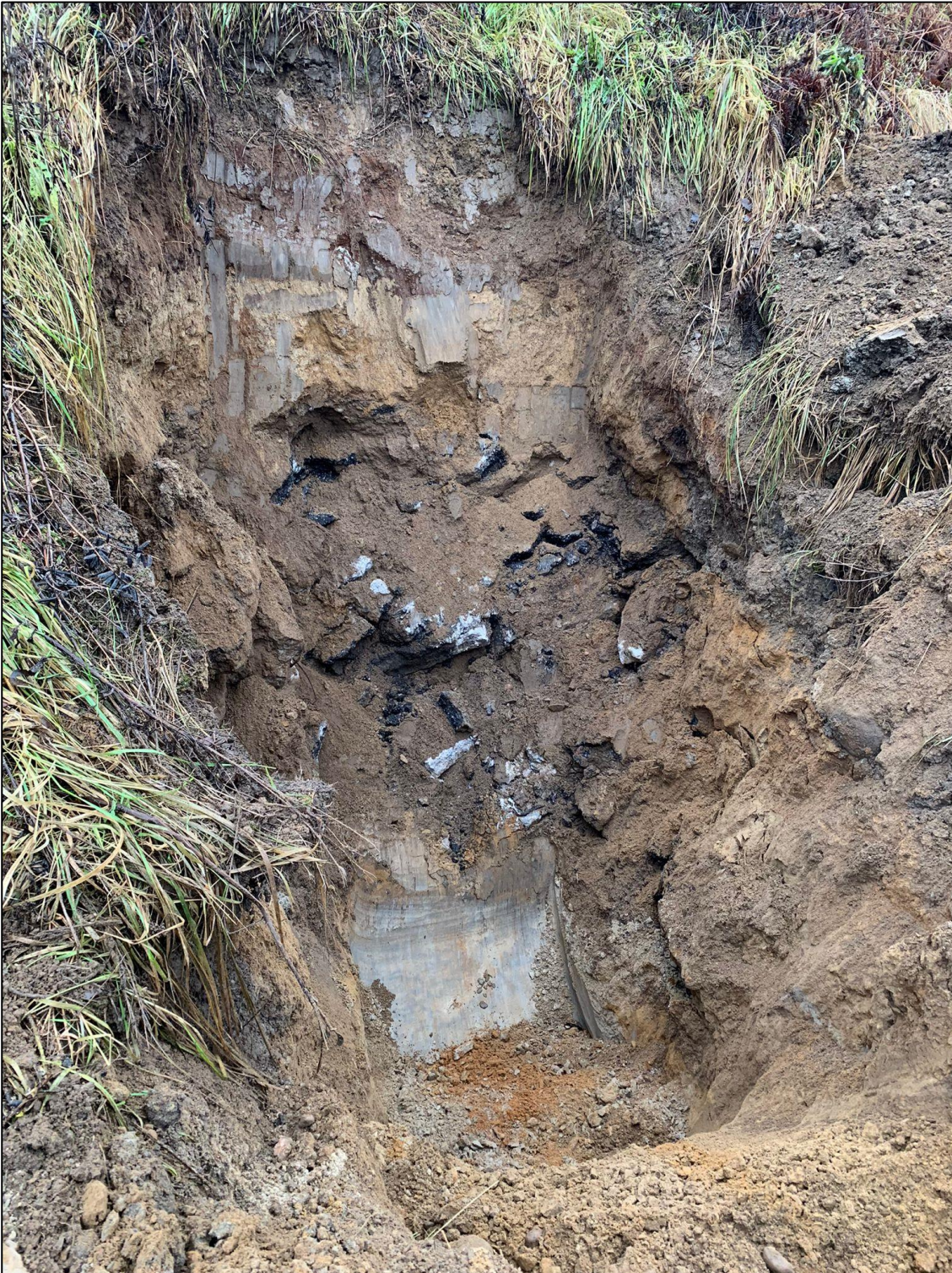
Kuva 3. Koekuopassa SE7 havaittiin asfalttia ja raudoitettua betonia.
